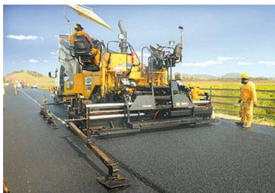
Figura 3: Pavimentação com Asfalto-borracha.
